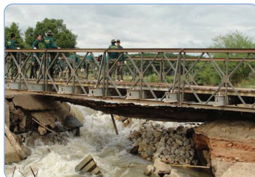
การติดตั้งสะพานแบริ่งช่วยเหลือนักท่องเที่ยว บริเวณฝายน้ำล้น หมู่ที่ 4 บ้านเสาหงส์ ตำบลหนองกุ่ม อำเภอบ่อพลอย
