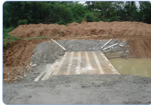
โครงการก่อสร้างฝายชะลอน้ำเพื่อแก้ปัญหาน้ำท่วม ลำห้วยบ้านหนองหมู หมู่ที่ 6 ตำบลหลุมรัง อำเภอบ่อพลอย
