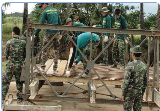
การติดตั้งสะพานแบริ่งช่วยเหลือนักท่องเที่ยว บริเวณฝายน้ำล้น หมู่ที่ 4 บ้านเสาหงส์ ตำบลหนองกุ่ม อำเภอบ่อพลอย
